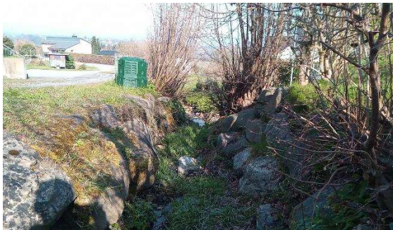
Blick abwärts, km 1.55
