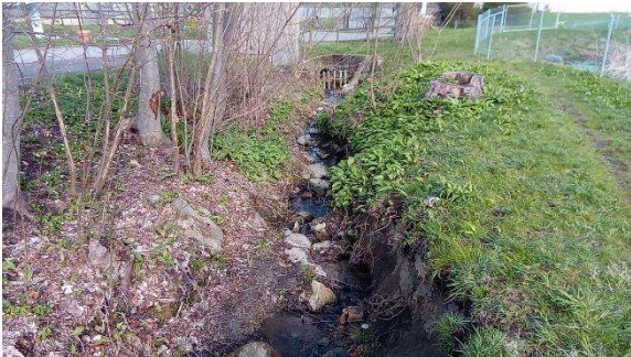
Blick gegen Eindolung, km 1.47, rechts eingezäunt: Retentionsbecken für die Strassenentwässerung
