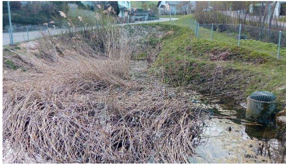
Retentionsraum Strassenentwässerung (Notüberlauf rechts)
