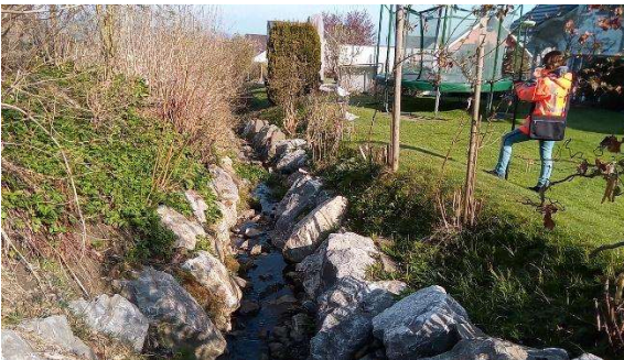
Durchlass, Blick abwärts, km 1.60
