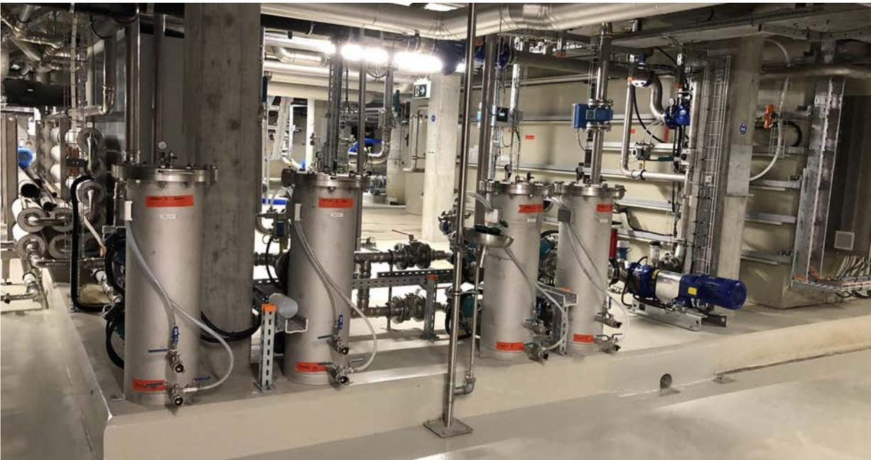
Mitte 2021 wurde die Membranstrippungsanlage in Betrieb genommen. Die Anlage ermöglicht die Düngergewinnung aus Schlammwasser.
