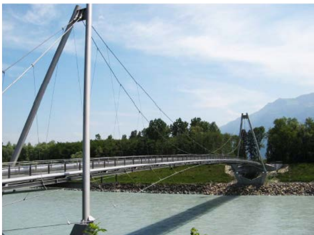
Mögliche Ausgestaltung der Fuss- und Velowegbrücke als Hängebrücke mit Trag-, Hänge- und Abspannseilen
